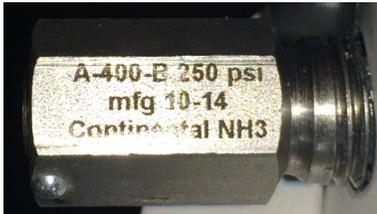
153-A-400-B 1/4" Hydrostat Relief Valve—250 PSI —
